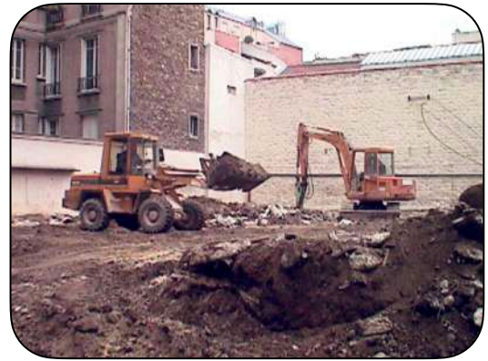
La cour de tennis en travaux, 1999
